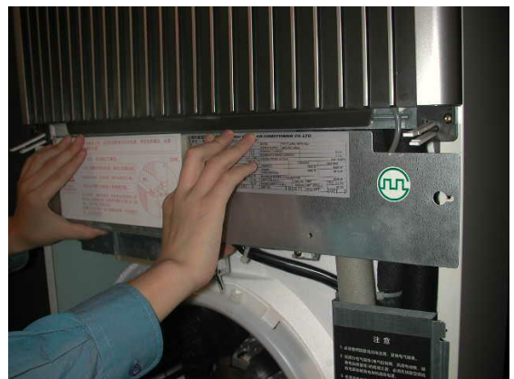
18. 盖上电气盒盖板；
